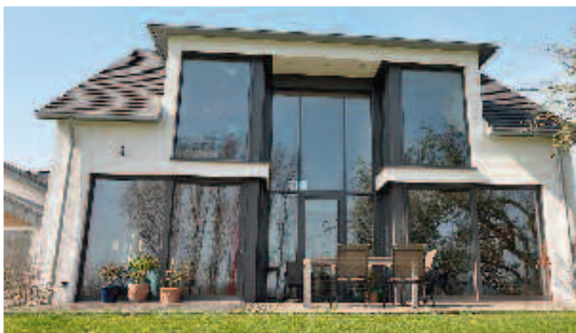
An diesem 2009 erbauten Einfamilienhaus in Aachen kam das Zöllner-Fenstersystem PlanumKlima in Kombination mit Pfosten-Riegel-Bauweise zum Einsatz.
