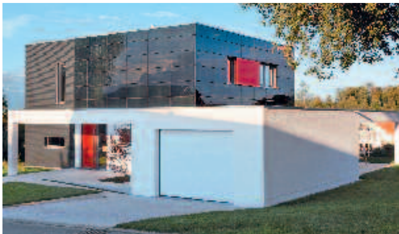
Auch Einfamilienhäuser verwandeln sich mit Dünnschicht-PV in Schmuckstücke.
