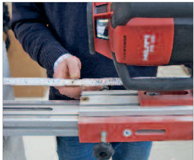
Jetzt schalten Sie den Hilti-Rotationslaser ein. Wenn der Referenzpunkt erscheint, justieren Sie den gewünschten Abstand zur Fassade.
