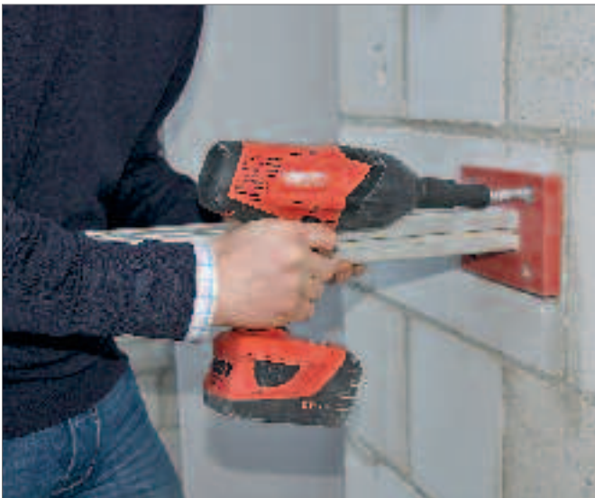
Montieren Sie den Fassadenadapter am äußersten Ende der Gebäudemauer für den Aufsatz des Rotationslasers.
