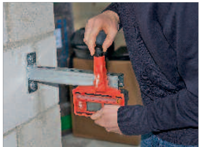
... und befestigen ihn auf der am anderen Ende des Gebäudes vormontierten Konsole.
