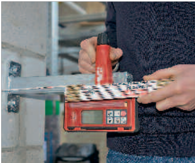
Im Anschluss stellen Sie mit dem Zollstock den gewünschten Abstand des Empfängers zur Fassade ein.
